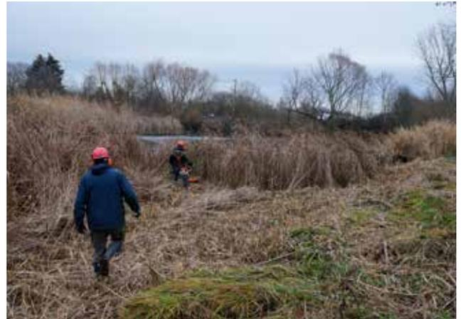
Nach Absenkung des Wasserstandes konnte dann Anfang Januar im zu entlandenden Bereich durch die Mitarbeiter unseres Verbandes das Schilf geschnitten werden. Am 16. Januar 2020 wurde dann mit schwerem Gerät der Teichschlamm innerhalb des Gewässers umverlagert, wodurch eine größere Verlandungszone beseitigt werden konnte.
