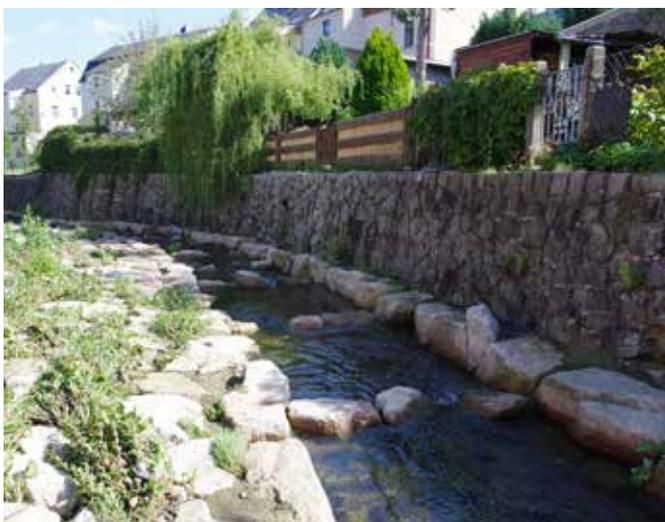
Abb. 1: Ansicht der geteilten Gleite, rechtsseitig die Riegelgleite und linksseitig eine Teilansicht der Blocksteingleite
